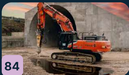
Maquinaria de movimiento de tierras
