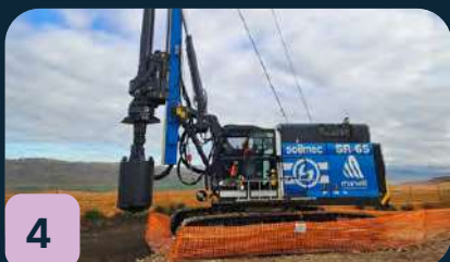
Maquinaria de perforación
