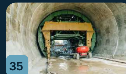
Andamios, encofrados y moldes
